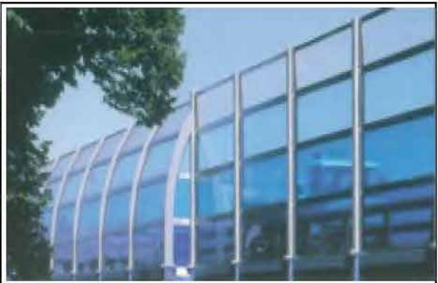
Plexiglas Soundstop GS différents tons de bleu Autoroute N 1, Morges ouest (Suisse)
