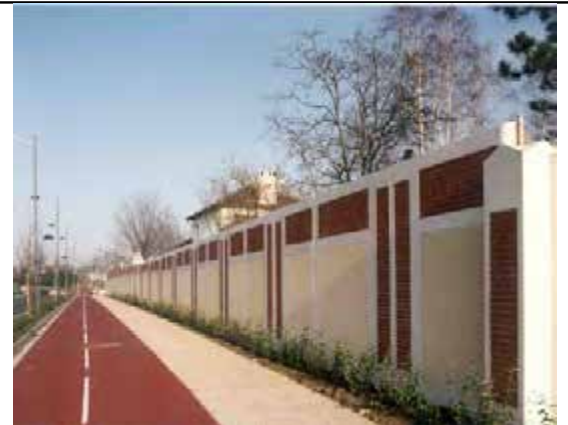
Saint Gratien – Ecran béton avec brique et gravillon lavé
