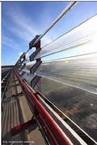
A71, Reichenbachtalbrücke-Ilmenau , lamelle CC
